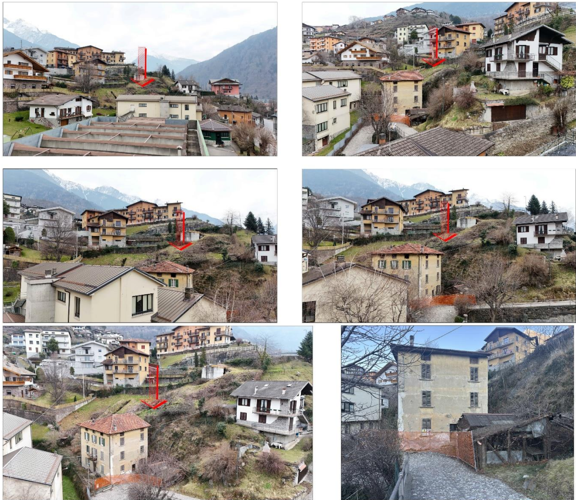
Figura 22 Rilievo fotografico - stato di fatto
